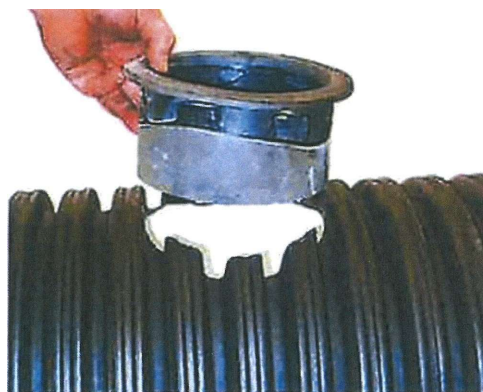
(montaggio della guarnizione a tenuta)
