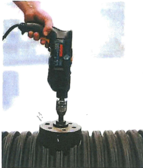
(foratura della condotta fognaria)
